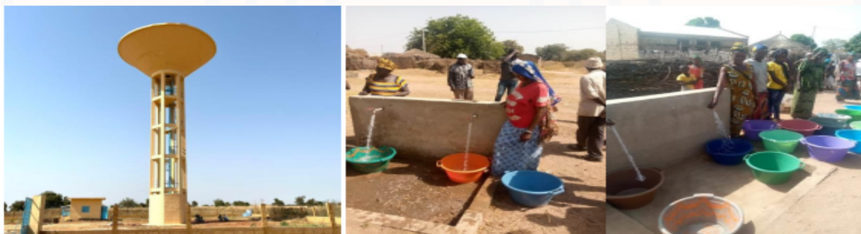
La réception du forage de Wouro Alpha Ly (Département de Podor, Région de Saint Louis)
