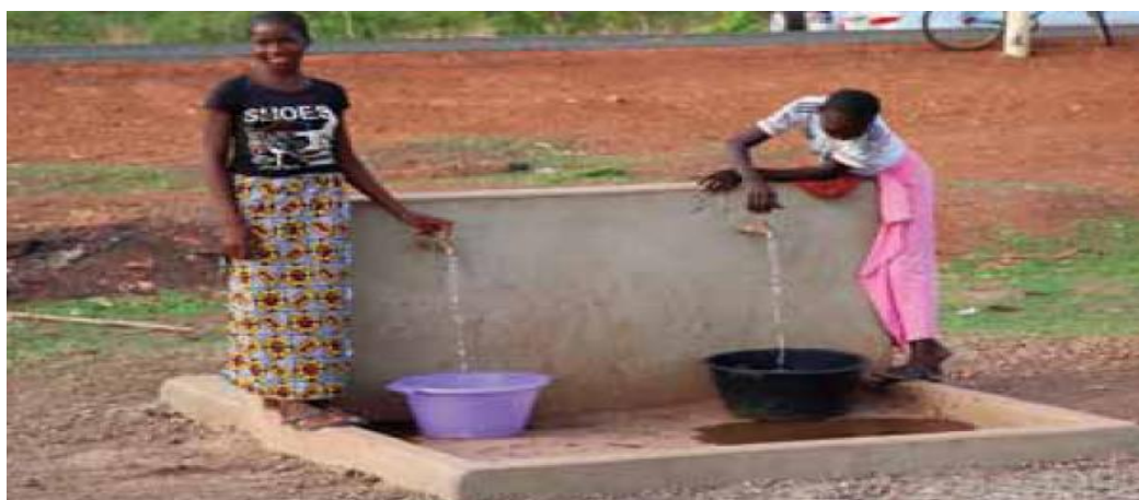
Accès à l'eau à Kédougou
